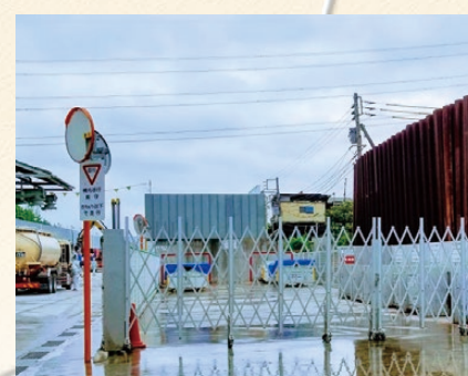
産業廃棄物積替保管施設
