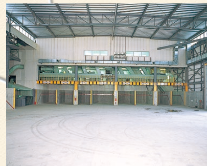
屋内ストックヤード
