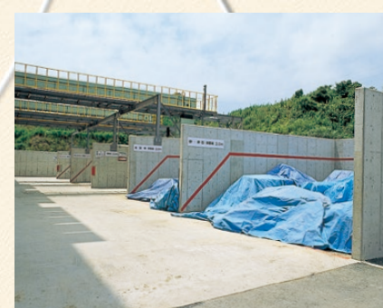
屋外ストックヤード
