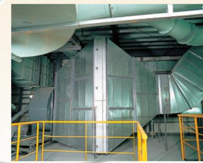
集塵機 / 精選別ヤードの粉塵を除去します。
