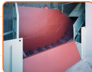
コンクリートがら投入口
