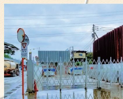
産業廃棄物積替保管施設
