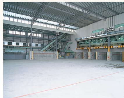
粗選別ヤード(高さ17m・広さ1300m 2 )
