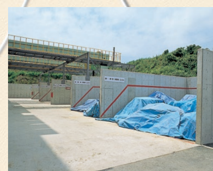
屋外ストックヤード
