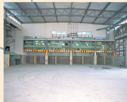
屋内ストックヤード
